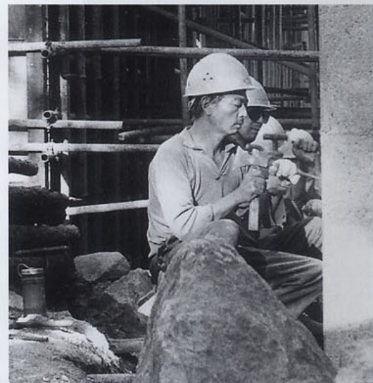
Après le décoffrage de la façade, les ouvriers vont s'employer pendant des jours à boucharder les lignes de jonction pour inscrire la trame en creux
